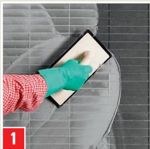
1 Beutelinhalt (5 kg) in ca. 1,4 l sauberes Wasser einrühren. Nach 5 Minuten nochmals durchrühren. Fugenmörtel mit Moosgummibrett diagonal in die Fugen einschlänmen. Überschüssiges Material abstreifen.
