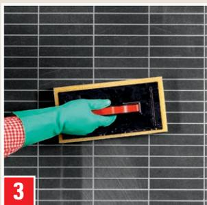
3 Mörtel ansteifen, d.h. matt werden lassen. Mit Schwamm/Schwammbrett reinigen. Schwamm/Schwammbrett wiederholt in klarem Wasser reinigen und gut ausdrücken.
