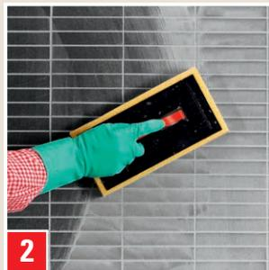
2 Mit Schwamm/Schwammbrett entlang der Fugen bügeln. Danach mit feuchtem Schwamm grob reinigen.
