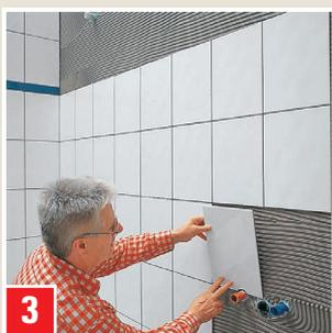
**3** Fliesen innerhalb 30 Minuten einschieben und ausrichten.
