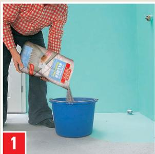
**1** Sackinhalt (18 kg) mit langsam laufendem Rührwerk in 8,1–8,5 l sauberes Wasser einrühren. Nach 5 Minuten nochmals durchrühren.
