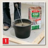
Anmischen: Sackinhalt (25 kg) in ca. 6,5 I sauberes Wasser mit langsam laufendem Rührwerkzeug einrühren. Nach 5 Minuten nochmals durchrühren.
