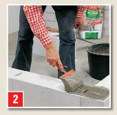
Lager- und Stoßfugen durch Abfegen entstauben. Klebstoff mit Plansteinkelle auf Lagerfuge aufziehen.
