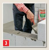
Klebstoff auch auf die Stoßfuge aufziehen. Bei Steinen mit Nut und Feder nur auf die Lagerfuge auftragen.
