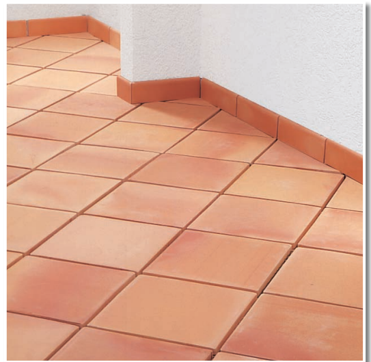
Cotto-Belag nach dem Verfugen mit SAUBERE SACHE abgésäuert.
