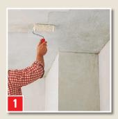
Deckenkassetten kleben: STYROPORKLEBER mit Fellrolle oder Zahnspachtel auf den Untergrund auftragen.
