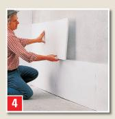
Styroporplatten kleben: STYROPORKLEBER aufrollen, Styroporplatte ansetzen und festdrücken.
