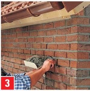
**Wasserabweisender Fugenmörtel in einem Verblendmauerwerk:** Einbringen des erdfeuchten Fugenmörtels.
