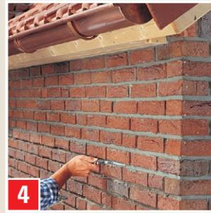
Glätten des Fugenmörtels mit Fugeisen.
