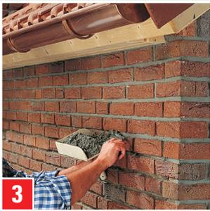
**3** Wasserabweisender Fugenmörtel in einem Verblendmauerwerk: Einbringen des erdfuchten Fugenmörtels.
