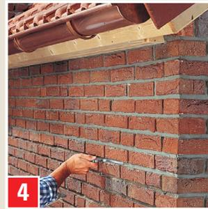
**4** Glätten des Fugenmörtels mit Fugeisen.
