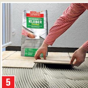
Coller les carrelages avec une colle agréée, par ex. SICHERHEITSKLEBER FLEXIBEL, SICHERHEITS-KLEBER FLEXIBEL PLUS ou GROSS-FORMAT-KLEBER Wand & Boden.
