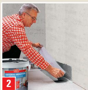
Appliquer UNIVERSAL-ABDICHTUNG sur la zone à étanchéfier, insérer directement le composant système (par ex. DICHTUNGSBAND) et ajuster immédiatement. Presser légèrement avec un outillage adapté et encastrer sans bulle ni pli. Les zones de raccordement doivent se chevaucher sur au moins 5 cm. Observer les indications de mise en œuvre des composants système.
