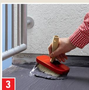
Appliquer une première couche uniforme de UNIVERSAL-ABDICHTUNG avec un outillage adapté (par ex. pinceau, truelle, talocheuse-lisseuse) (épaisseur de couche 1–1,25 mm). Traiter les parties encastrees en les recouvrant. Laisser sécher pendant au moins 2 heures.
