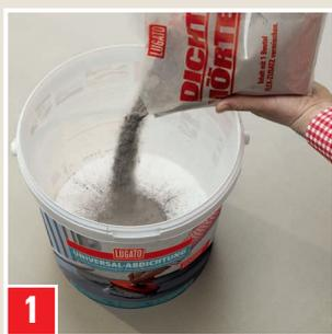
Verser 3,2 kg d'additif Flex dans le récipient de mélange (par ex. seau de l'emballage). Incorporer 3,8 kg de mortier d'étanchéité avec un agitateur électrique sur vitesse lente pour obtenir un mélange homogène exempt de grumeaux.
