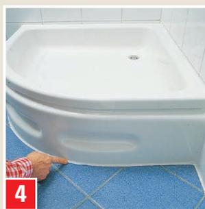
Dans les 10 minutes qui suivent la pose, lisser le joint avec la FUGENGLÄTTER (humidifiée avec le mastic de lissage SILICONGLÄTTMITTEL).
