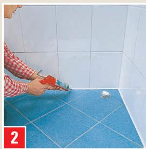
Étanchéification durablement élastique des joints de sol avant de poser le receveur de douche.
