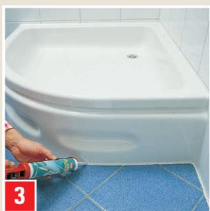
Étanchéification des joints de raccordement entre le receveur et le carrelage au sol.
