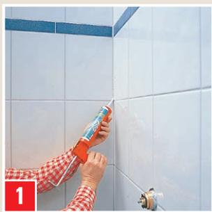
Étanchéification durablement élastique des joints d'angle.
