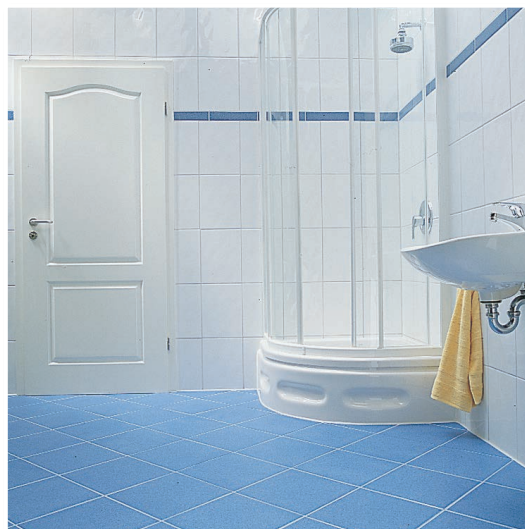
La douche une fois terminée. Joints d'angle et de raccordement étanches et élastiques.
