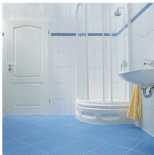
La douche une fois terminée. Joints d'angle et de raccordement étanches et élastiques.
