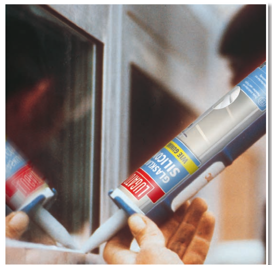
Fensterfalzversiegelung zwischen Glas und Alurahmen.
