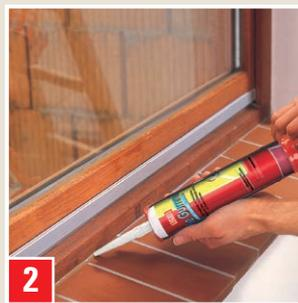
Étanchéification entre le cadre de la fenêtre et l'appui de fenêtre.
