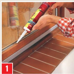
Étanchéification d'une feuillure de fenêtre entre la vitre et le châssis en bois.
