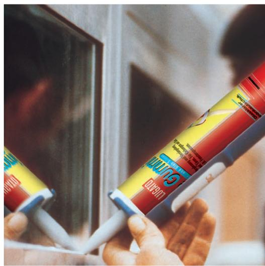
Étanchéification d'une feuillure de fenêtre entre la vitre et le châssis en aluminium.
