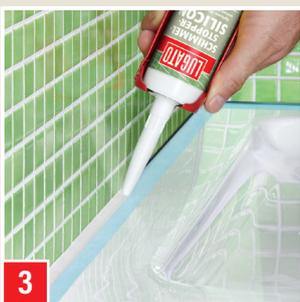
3 Injecter SCHIMMEL-STOPPER-SILICON en couche épaisse dans le joint à l'aide du pistolet à cartouche.
