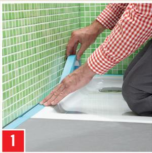
1 Avant la réalisation des joints élastiques coller du ruban adhésif au niveau des bords des joints.
