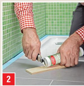
2 Düsen Spitze schräg (entsprechend der Fugenbreite) und Kartuschenspitze abschneiden.
