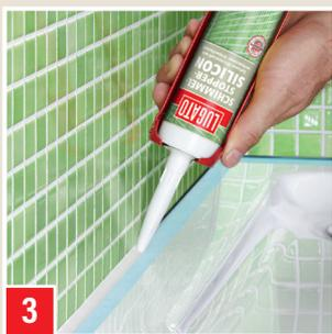
3 SCHIMMEL-STOPPER-SILICON mit Auspresspistole satt in die Fuge ausspritzen.
