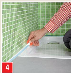
4 Innerhalb 20 Minuten mit FUGENGLÄTTER (angefeuchtet mit SILICONGLÄTTMITTEL) glätten. Klebeband sofort abziehen, Fugenränder nachglätten.
