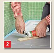
Düsenspitze schräg (entsprechend der Fugenbreite) und Kartuschenspitze abschneiden.
