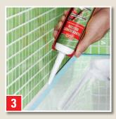
SILBERSCHUTZ-SILICON mit Auspresspistole satt in die Fuge ausspritzen.
