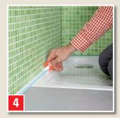
Innerhalb 20 Minuten mit FUGENGLÄTTER (angefeuchtet mit SILICONGLÄTTMITTEL) glätten. Klebeband sofort abziehen, Fugenränder nachglätten.
