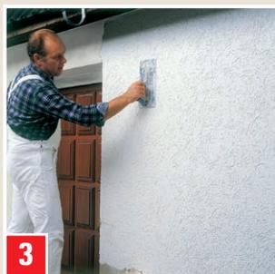
Innerhalb 10-20 Minuten mit Kunststoffglätter strukturieren. Waagrecht, senkrecht, kreisförmig oder diagonal.
