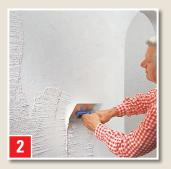
Mélanger le crépi au brasseur. Adapter la consistence, si nécessaire avec 100–200 ml d'eau. Appliquer le crépi sur une truelle lisseuse en acier. Utiliser des outils en inox.
