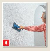
Donner la structure voulue en 10–20 minutes avec une truelle en plastique. Frotter horizontalement, verticalement, en cercle ou diagonale.
