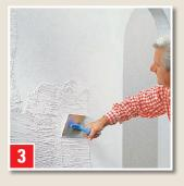
Répartir à l'épaisseur de grain voulue avec la truelle lisseuse en acier perpendicualire au mur.
