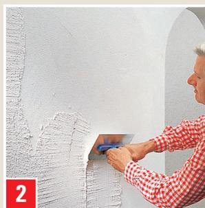
Putz mit Rührwerk durchrühren. Putz auf Stahlglätter geben und aufziehen. Rostfreies Werkzeug verwenden.
