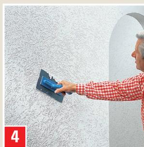
Innerhalb 10–20 Minuten mit Kunststoffglätter strukturieren. Waagrecht, senkrecht, kreisförmig oder diagonal reiben.
